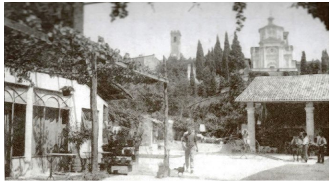
Albergo Gatta da cui sono state ricavate le aule di catechismo nel 1925
